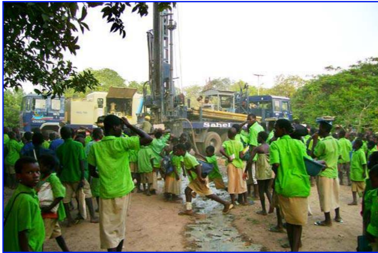
Wasserbohrung auf dem Schulhof
